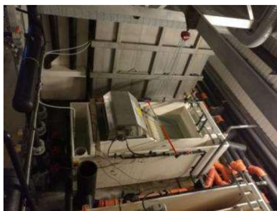
تصویر ۱۸- نمای دستگاه درام فیلتر مورد استفاده در سیستم مدار بسته
